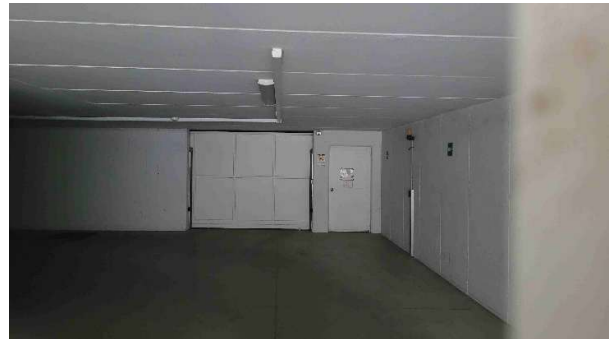
Corsia di manovra 1. Piano interrato
