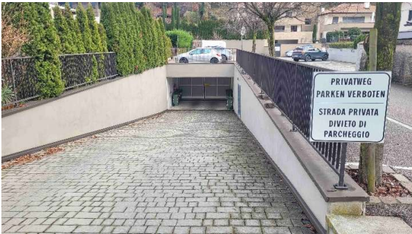
Rampa di accesso ai garage
